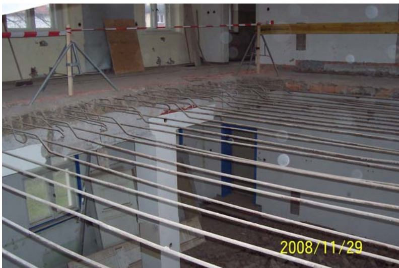
Abbildung 2: Verstärkung der Geschosßdecken im Bereich der beiden großen Labore. (Foto: Tobias Winkler)
