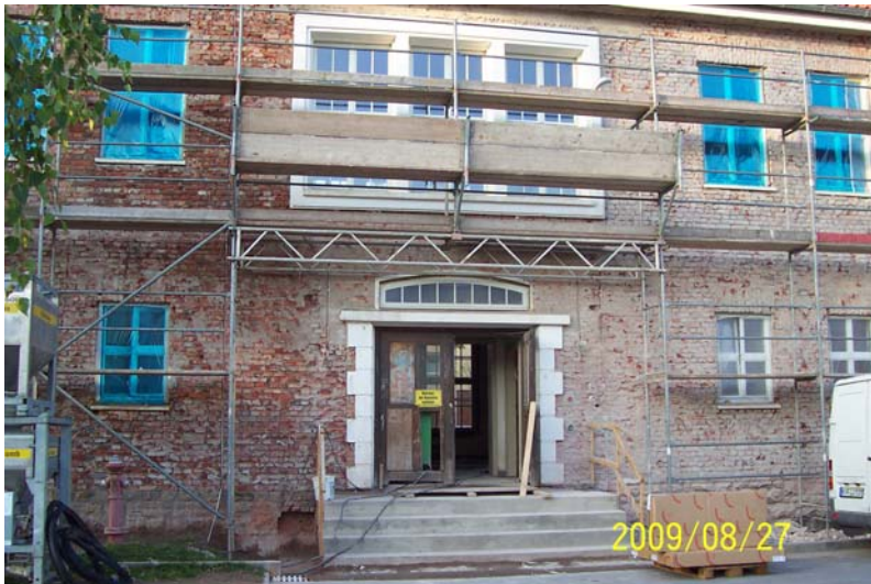
Abbildung 1: Frontansicht des Gebäudes 34 vor der Wärmedämmung der Außenfassade. (Foto: Tobias Winkler)
