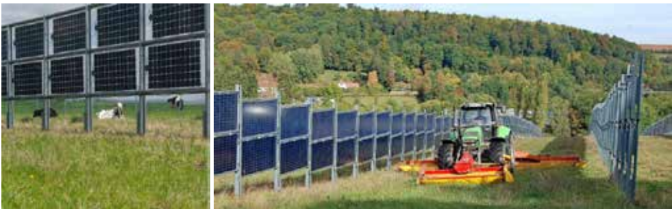
Abb. 1: 90° aufgeständerte bifaziale PV Module im Feld (Quelle Next2Sun, D)
