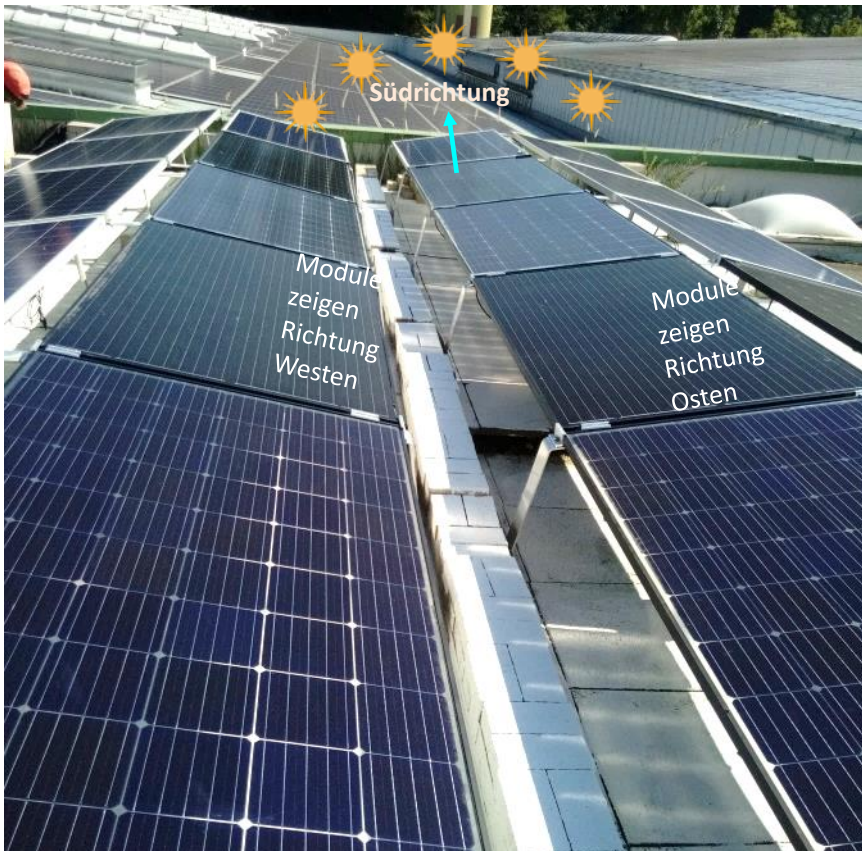
Abb. 16: Optimierung von verschattenden Anschlussdosen, Rahmen und Bifazialität
