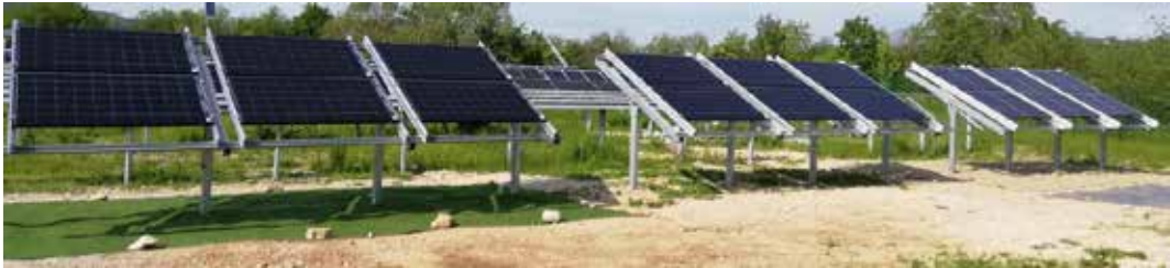
Abb. 1: Die drei Südsysteme mit den verschiedenen Bodenarten – Von links nach rechts: Kunstrasen, Bestandsboden, Mainkies
