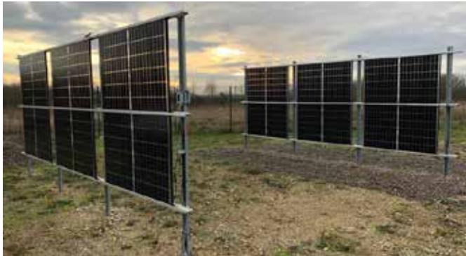
Abb. 2: Ost/West-Systeme mit den Untergründen Bestandsboden und Mainkies
