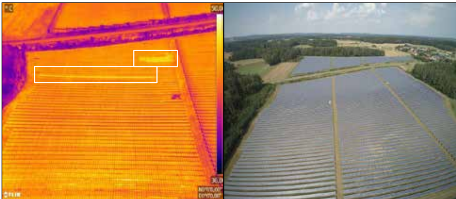
Abb. 4: PV-Generator mit einzelnen Modulsträngen im Leerlauf aufgrund von Erdschluss
