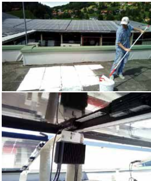
Abb. 14: Vorbereiten der reflektierenden Bodenfläche sowie Untersicht eines Moduloptimierers
