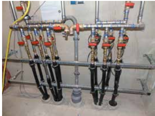
Abbildung 2: Geothermiesondenverteiler
