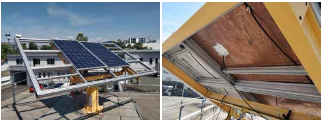
Abb. 4: Installierte Module auf dem Tracker (links); Isolation der Rückseite eines der beiden Module (rechts) [14]
