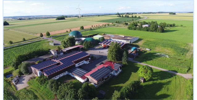
Energiehof Weitenau (©Juliane Vees)
