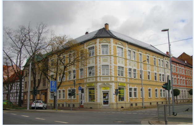
Dach-PV-Anlage in Nordhausen, Grimmelallee (©Dagmar Everding)
