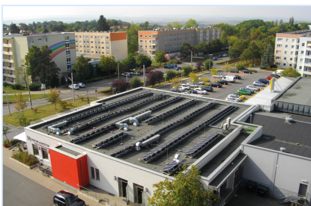
PV auf Flachdach in Nordhausen-Nord (©Dagmar Everding)
